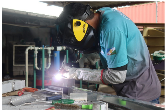
Realização das aulas práticas de soldagem MIG/MAG
